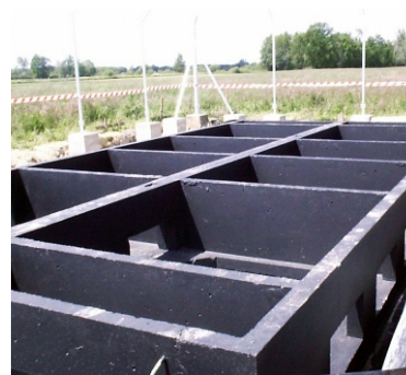
montaż fundamentu
